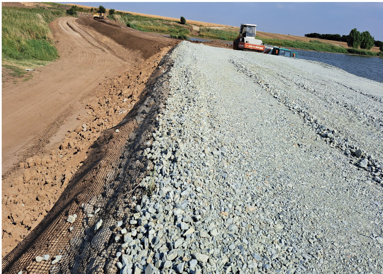
Materialul de umplutura dupa compactare
