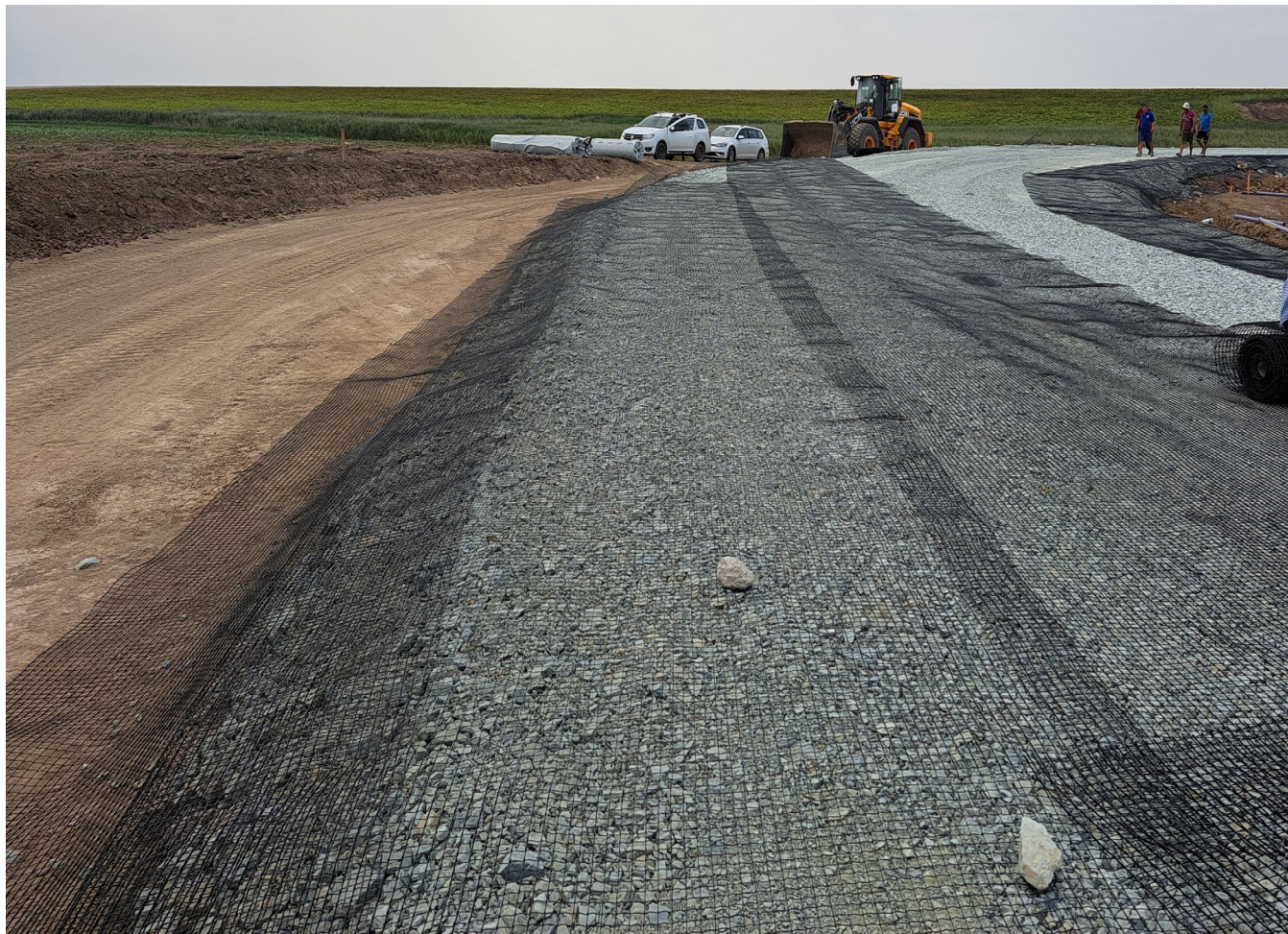
Surplus lateral de geogrila pentru realizarea intoarcerii
