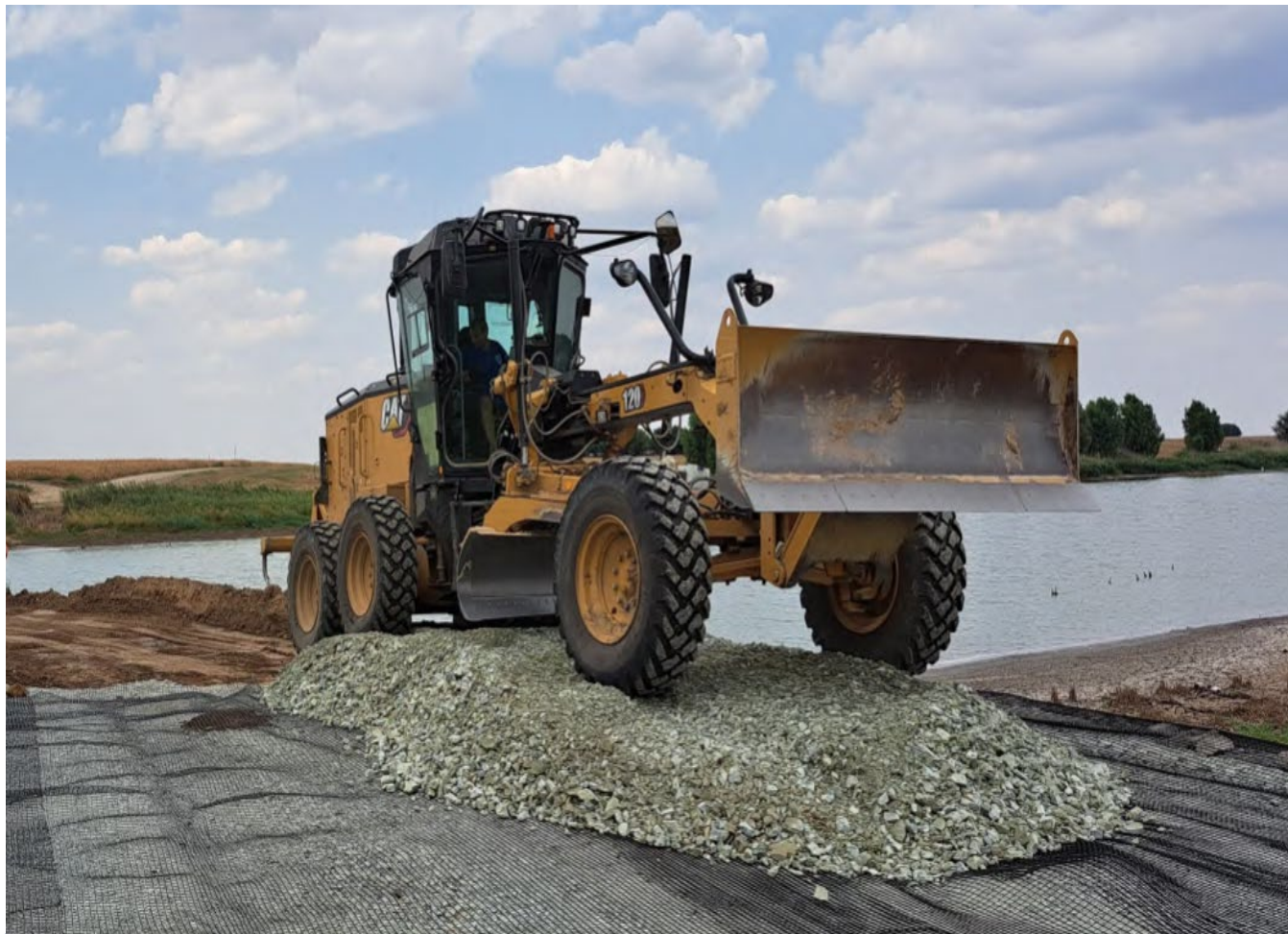
Raspandirea materialului de umplutura fara a intra cu rotile pe suprafata geogrilei
